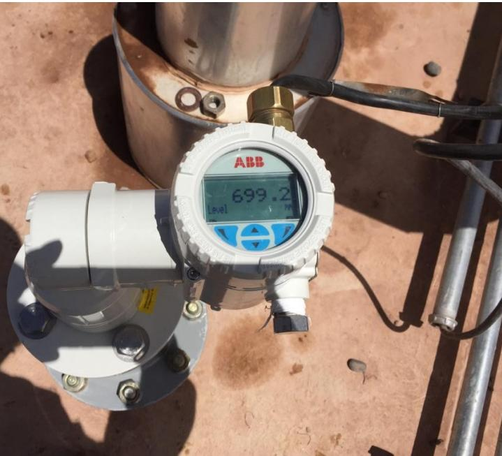
El transmisor de nivel láser LLT100 es la solución para los depósitos de la industria del petróleo y el gas
