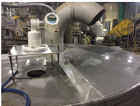
05 Control del nivel de espuma en un tanque desgasificador en la industria de la pulpa y papel
